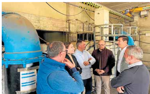
Visita al depósito de agua del municipio. IDEAL
