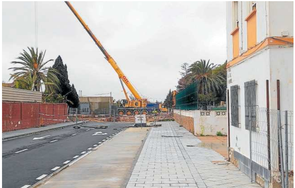
La ejecución del nuevo colector de la calle Aurora está condicionada a que el tanque esté operativo parcialmente // L.M.
