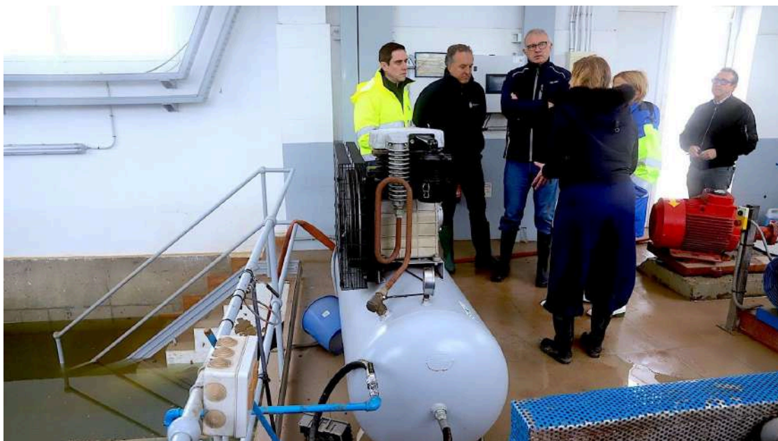
El delegado Jaime Espinar, durante la visita a la depuradora de El Portal, acompañado por técnicos.
